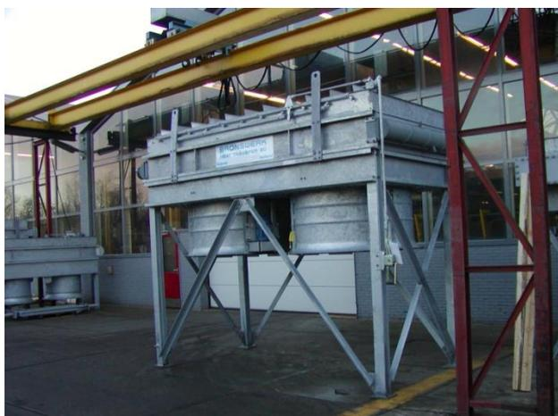
この設備に使用される空冷熱交換器において、管側の伝熱速度を増加させる促進技術の選択肢が存在する。この種の応用で広く採用されている hiTRAN 素子は、理想的な乱流を形成させる着脱可能なワイヤマトリックスであり、層流/ 遷移領域の状態、何も挿入していない平滑管に比べて、顕著で良好な伝熱促進と圧力損失の比率を示す。それらは管壁の流体を分配させ、乱流性を増加させる半径方向への攪拌を、推進する。hiTRAN の理想的な操作範囲はレイノルズ数が 100~5000 の範囲であるが、この範囲外においても効果的である。
